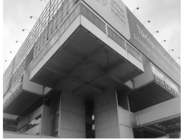
Şekil 13. Ofis Binası'nın 11m uzunluğundaki konsolu
