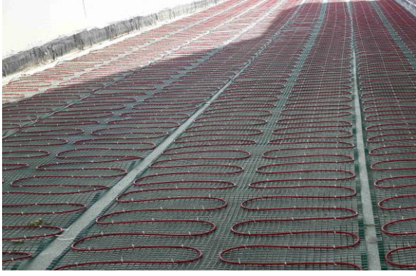
Şekil 3. Elektrikli kablolu kök ısıtma sistemleri
