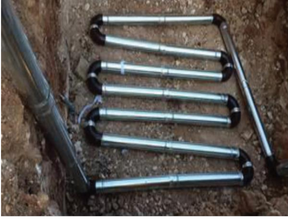
Şekil 12. Sera altına döşenen borular (Bulut vd., 2016)
