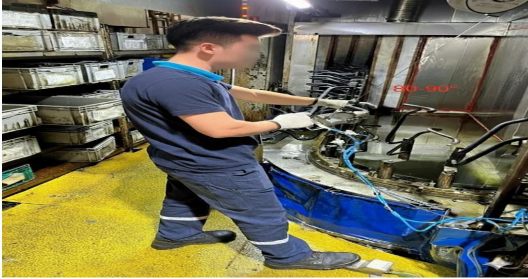
Şekil 15. Pompa yardımı ile kauçukların takılması (Installing rubber seals with the help of a pump)
