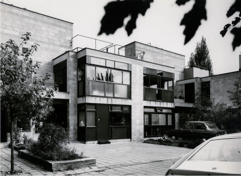
Şekil 3: Hermann Hertzberger - Diagoon Evleri 1967-1970 Kaynak: https://www.ahh.nl/images/projecten/woningbouw/DdB/L.jpg (Erişim: 01.02.2025)
