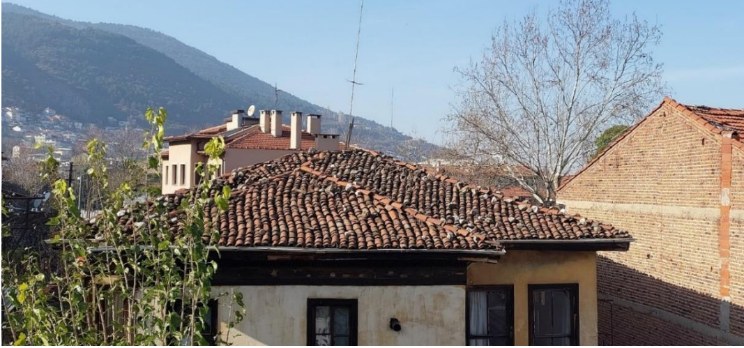
Şekil 28: Çatıdaki kiremitlerin düşmemesi için eklenen taşlar ve anten için açılan delik
