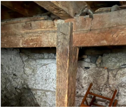
Şekil 24. Bodrum katta uygulanan düz bindirme
