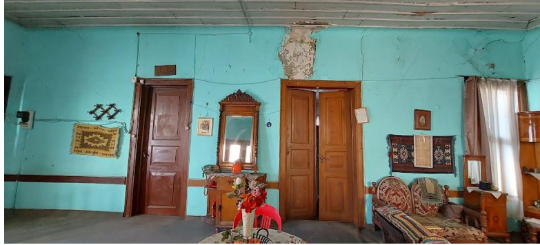
Şekil 10. 101 Sofa güney duvarı
