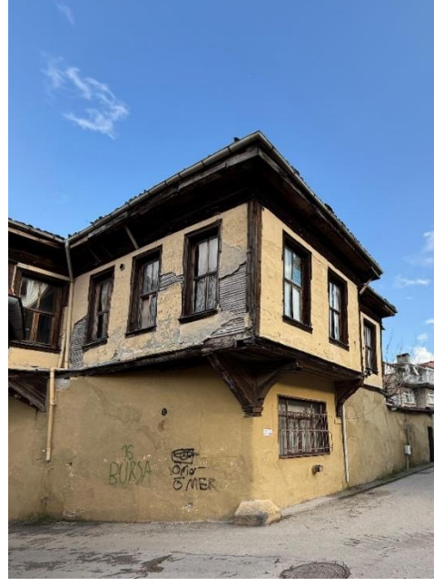
Şekil 23. Dökülen sıva tabakasının altından görülen bağdadi çıtalar.
