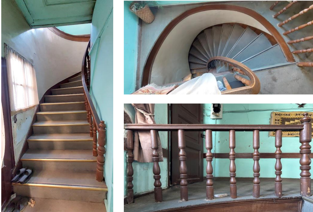
Şekil 29. Dengelenmiş ahşap merdiven
