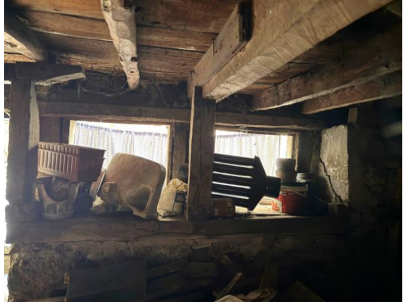
Şekil 24. Bodrum katta uygulanan düz bindirme
