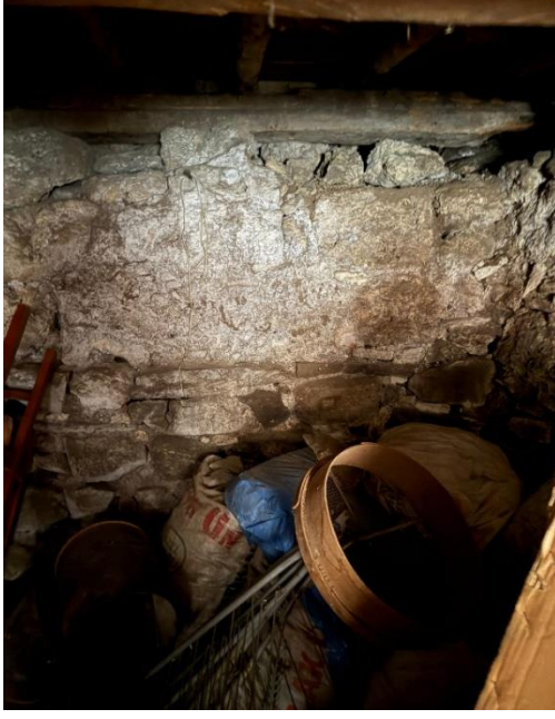
Şekil 22. Bodrum kat duvarı
