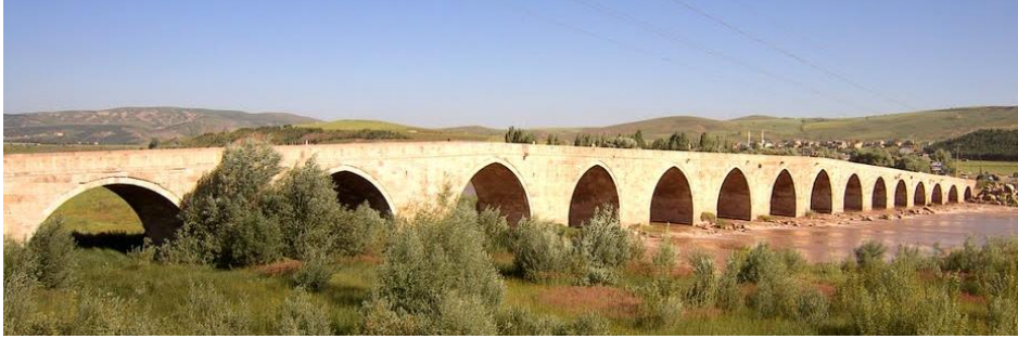
Fotoğraf 7. Sivas-Kayseri yolu, Kesik Köprü, genel görünüm
