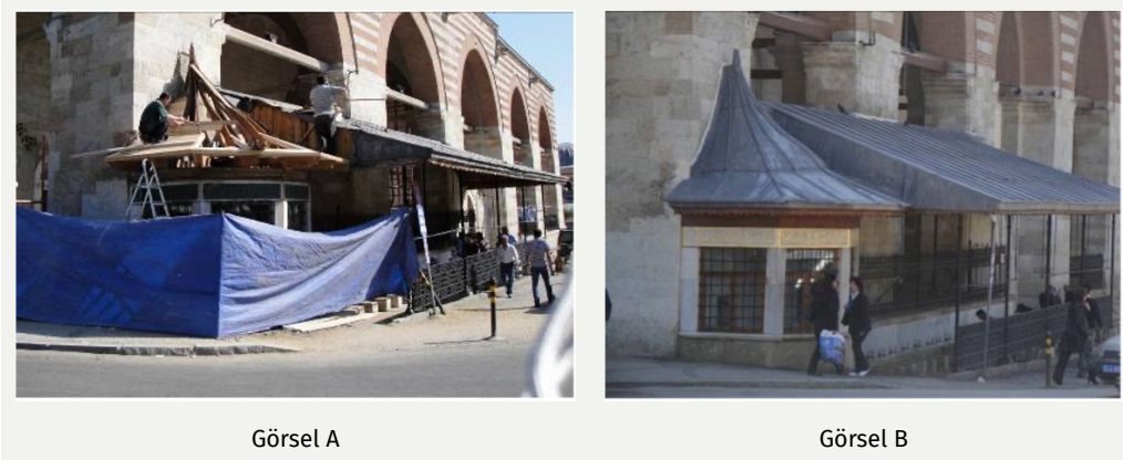
Görsel 24: a. Sebilin Onarım Aşaması, b. Onarım Sonrası
