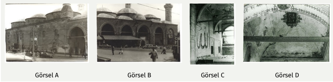
Görsel 8: 1983 Yılı Onarımı Öncesi a. Kuzeydoğu Cephesi, b. Son Cemaat Yeri, c-d. Son Cemaat Yeri, Kubbe ve Duvar Yüzeyi Kaynak: EVBM Arşivi
