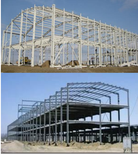
Şekil 1. Tipik arakatlı endüstri yapısı örnekleri
