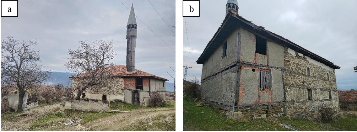
Şekil 9. a. Kuzeydoğu Cephe [7], b. Kuzeybatı Cephe [7]
