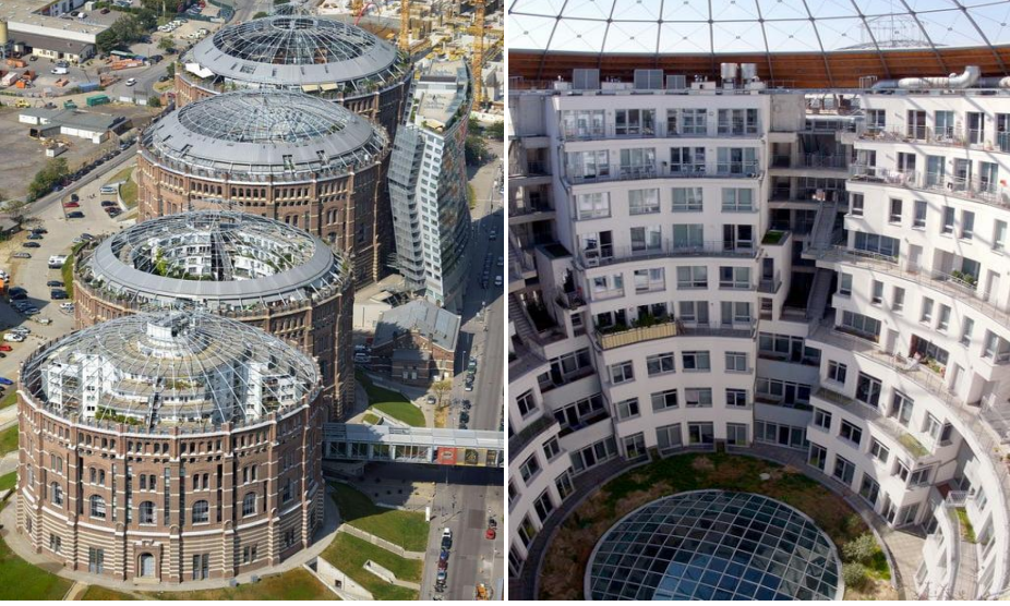
Şekil 5. Gazometre şehri dış görünümü (solda), iç görünümü (sağda) (Gasometers Complex, 2013)
