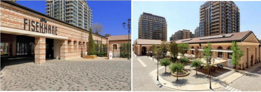
Şekil 7. Fişekhane yapısı dış görünüm (Zeytinburnu, İstanbul) (Toros Gazetesi, 2023)
