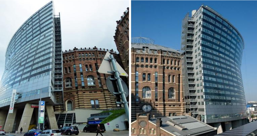
Şekil 6. Gazometre Şehri yapılarına sonradan eklenen yapı detayları (Gasometer City) (Solda), (Sağda) (Gasometers Complex, 2013)
