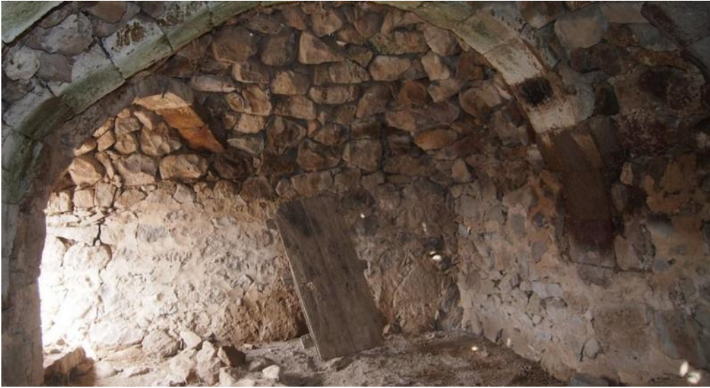
Figür 3: Türbe girişi ve girişte dikey atılan kemer uygulamasının görünüşü.
