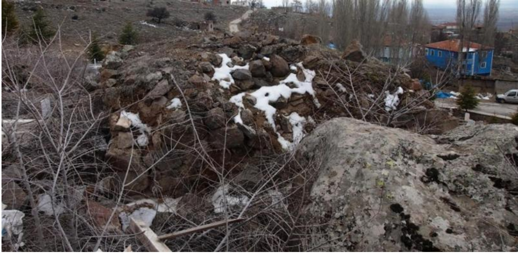
Figür 7: Kuzey yönden türbenin toprak damının görünüşü.
