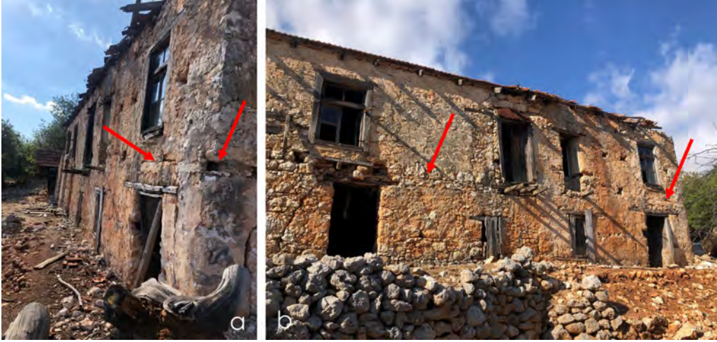
Görsel 24: Duvarlardaki Derzler (E4) (Armutçukuru Mevki)
