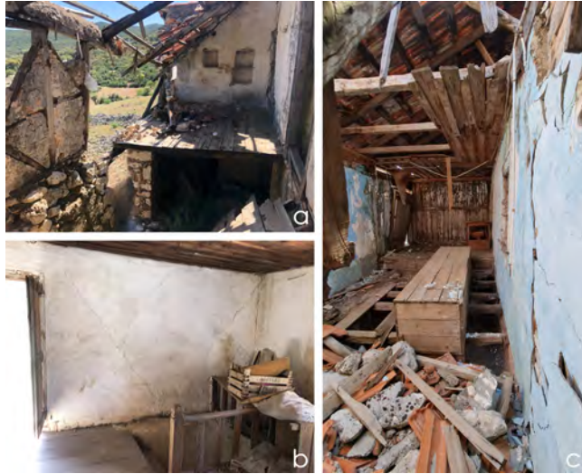
Görsel 11: Sofa Örnekleri: a. Ahşap Merdivenle Ara Yerden Çıkılan Sofa (E5), b. Taş Merdiven ile Ahırdan Çıkılan Sofa (E5), c. Taş Merdiven ile Dışarıdan Çıkılan Sofa (E8)
