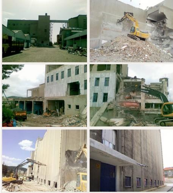
Resim 4. Fabrikanın Silolarının ve Tüm Müştemilatının Yıkım Görüntüleri 2008 33
