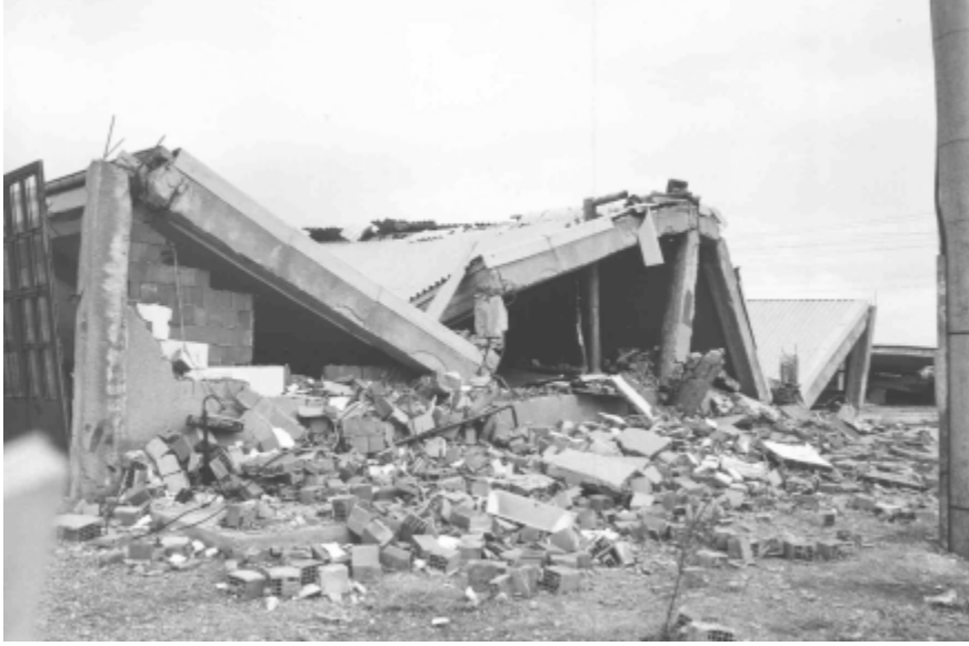
Şekil 8. Çay İlçesi sanayi sitesinde bulunan tamamen göçmüş bir bina.
