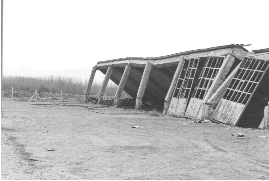
Şekil 9. Çay İlçesi sanayi sitesinde bulunan binalarda alt ve üst uçları mafsallaşmış kolonlar.
