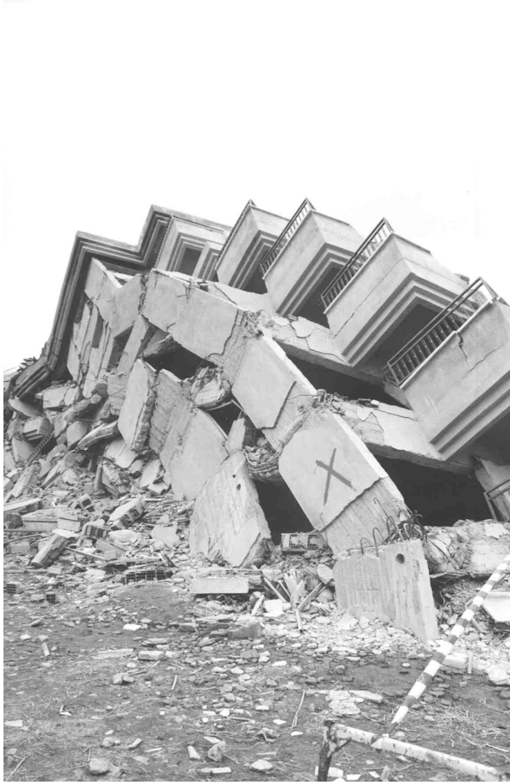
Şekil 10. Yeşil Çay Konut Yapı Kooperatifine ait toptan göçmüş 9 katlı betonarme yapı.
