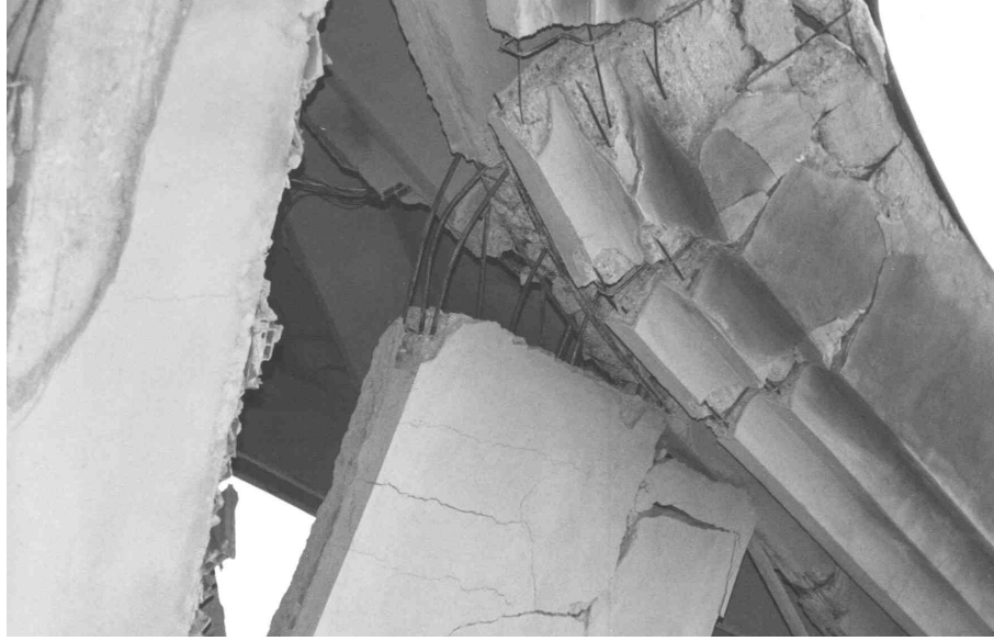
Şekil 11. Perde-kiriş düğüm noktasında perdeden sıyrılmış perde boyuna donatıları ve soğuk derz.
