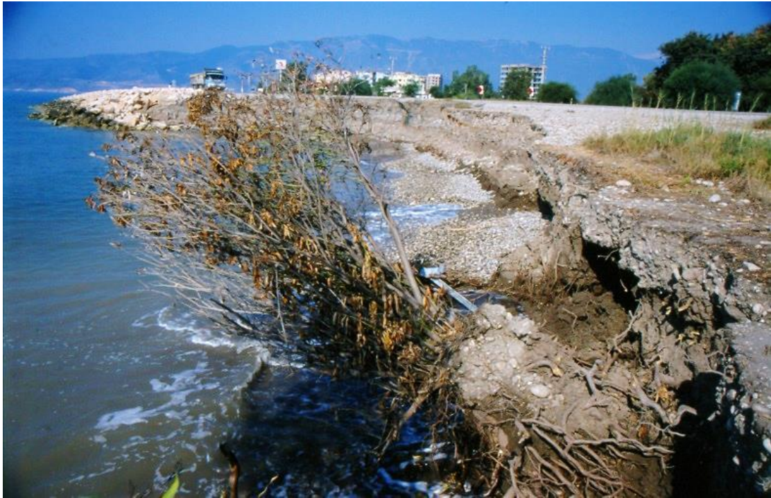
Foto 7: Alakır çayının eski ağız çıkıntısı boyunca kıyıda aşınma başlamıştır. Karayolu da bu aşınmanın etkisinde kalmıştır. Karayolu asfaltının bir bölümü dalgalar tarafından aşındırılmıştır. Aşınmayı durdurabilmek için yaklaşık 2km'lik kıyı boyunca dolgu çalışmaları yapılmıştır.
