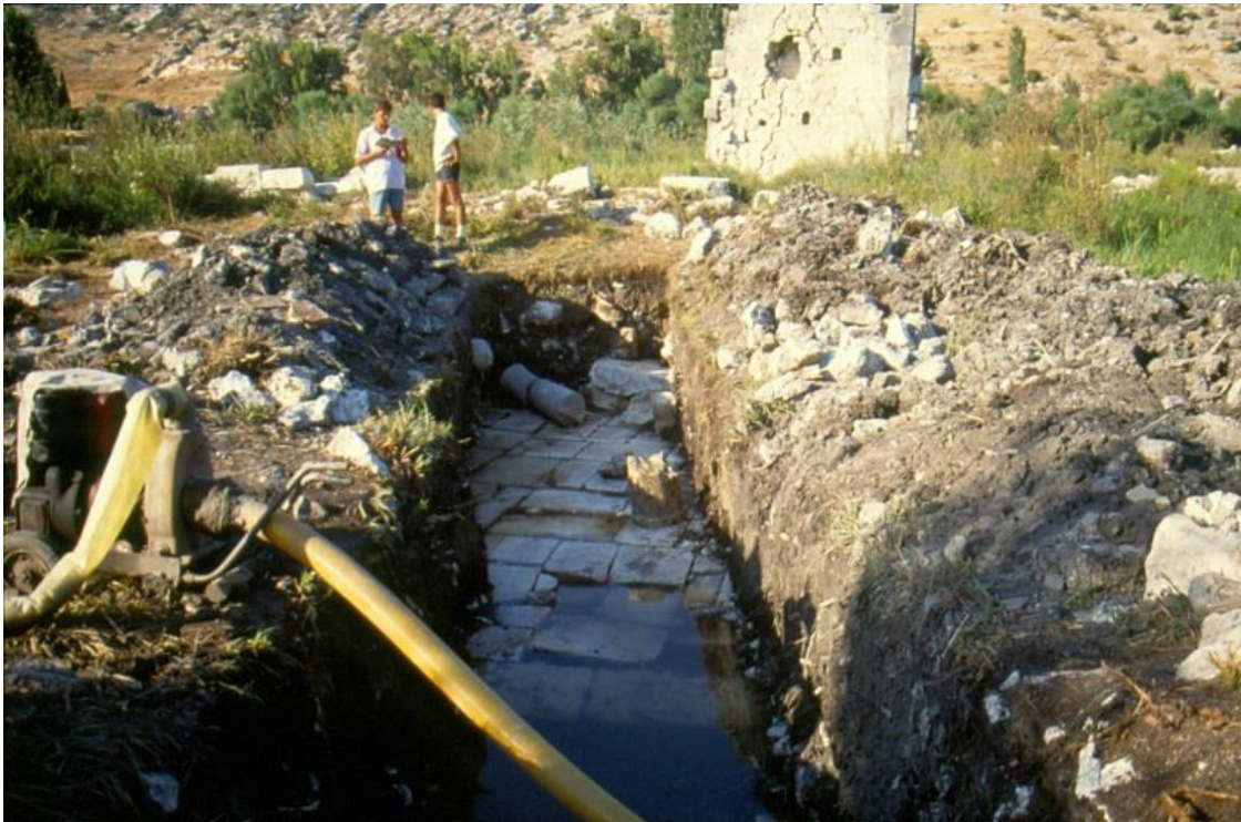
Foto 4: Limyra kentinin ova alanındaki yapıları da büyük ölçüde alüvyal malzemeler ve bataklık sedimanları ile örtülmüştür.
