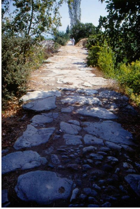
Foto 6: Alakır Çayı üzerindeki antik köprü yaklaşık 400 m kadar uzunluktadır. Bugün antik köprünün yalnızca yürüme yüzeyi açıkta olup ayakları büyük ölçüde Alakır Çayının alüvyonları altında gömülüdür.
