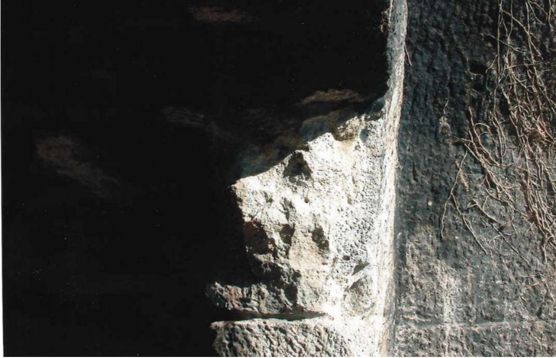
b. Tozkoparan Kaya Mezarının Ön Mezar Odasının Girişinin Sağ Tarafındaki Kabartma Boğa Başı
