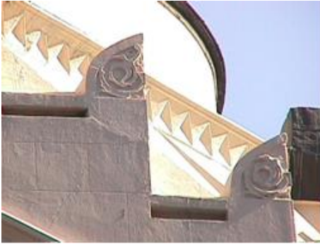
Resim 27. Sinema binası, batı cephe, bezeme detay
