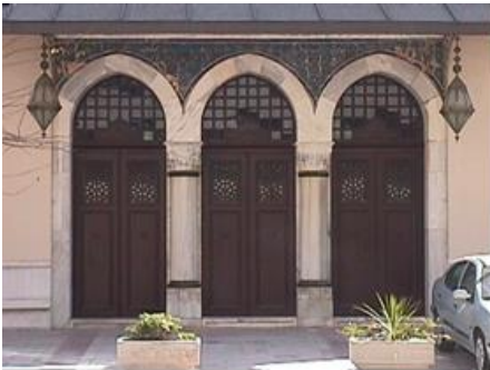
Resim 21. Sinema binası, batı cephe, giriş
