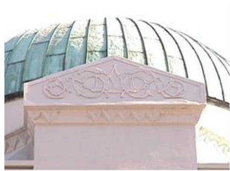
Resim 28. Sinema binası, batı cephe, bezeme detay
