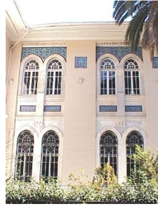
Resim 48. Kütüphane binası, batı cephe
