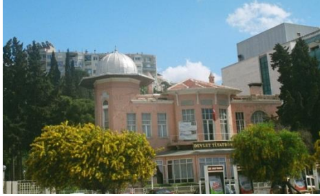
Resim 61. İzmir Eski Türk Ocağı binası
