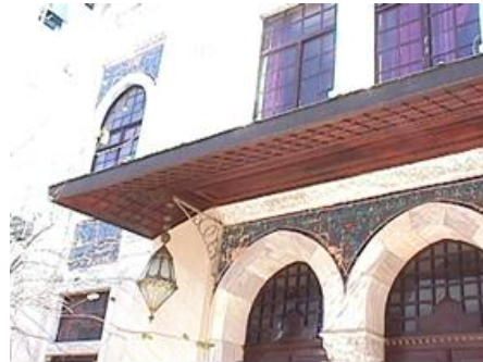
Resim 22. Sinema binası, batı cephe, giriş, detay
