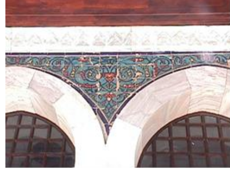
Resim 30. Sinema binası, batı cephe, detay
