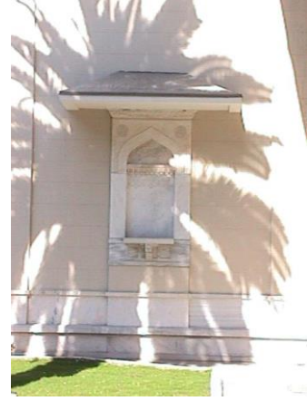
Resim 26. Sinema binası, güney cephe, sebil
