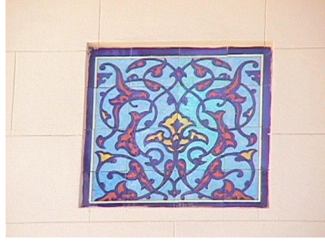
Resim 50. Kütüphane binası, batı cephe, detay
