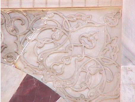
Resim 55. Kütüphane binası, giriş, kemer köşeliği
