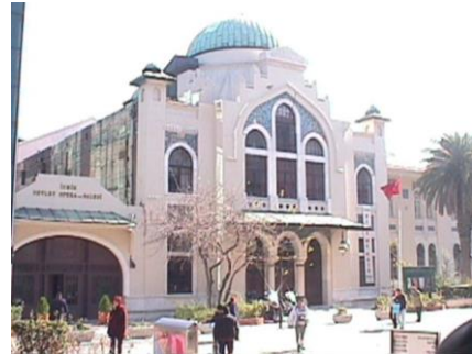
Resim 4. Milli Sinema binası, batı cephe (Şimşek Özel, 2013)
