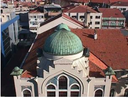
Resim 19. Sinema binası, çatı ve kubbeler
