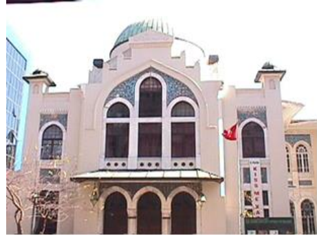
Resim 20. Sinema binası, batı cephe
