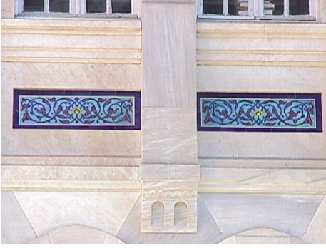
Resim 49. Kütüphane binası, batı cephe, detay
