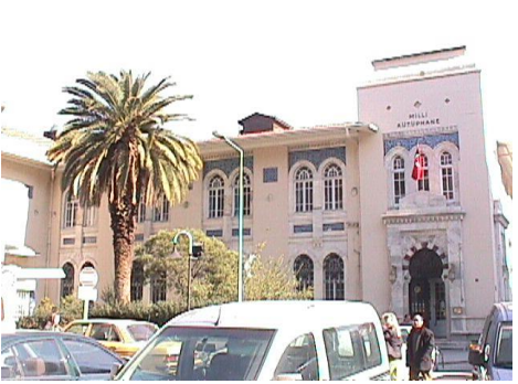
Resim 44. Kütüphane binası, batı cephe
