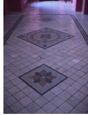
Resim 7. Sinema binası, giriş holü, zemin döşemesi
