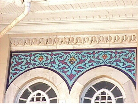
Resim 51. Kütüphane binası, batı cephe, detay
