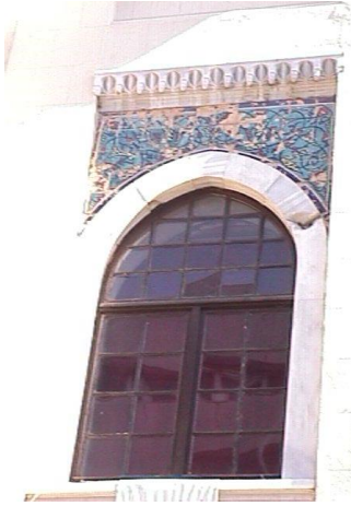
Resim 23. Sinema binası, batı cephe, detay
