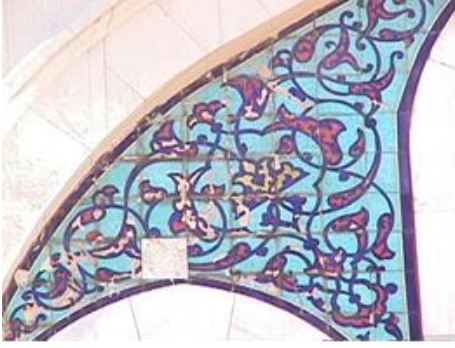
Resim 29. Sinema binası, batı cephe, çini kaplama, detay
