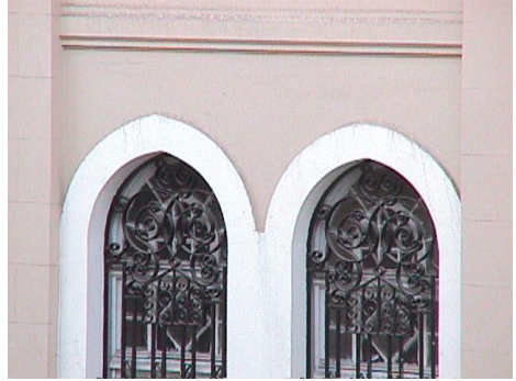
Resim 52. Kütüphane binası, güney cephe, detay
