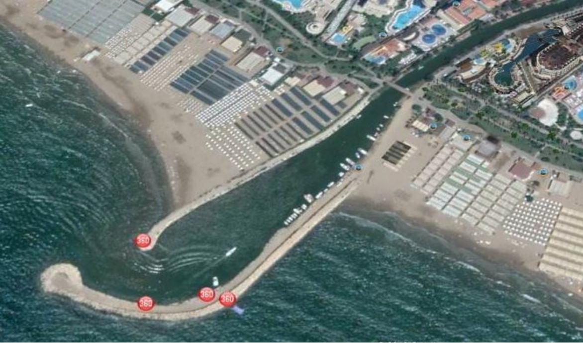
Şekil 10. Önemli yılanbalığı habitatlarından, Demirciler Deresi (Manavgat)'nin akarsu ağızındaki yapay yapılaşma örneği ve yoğun tekne trafiği.
