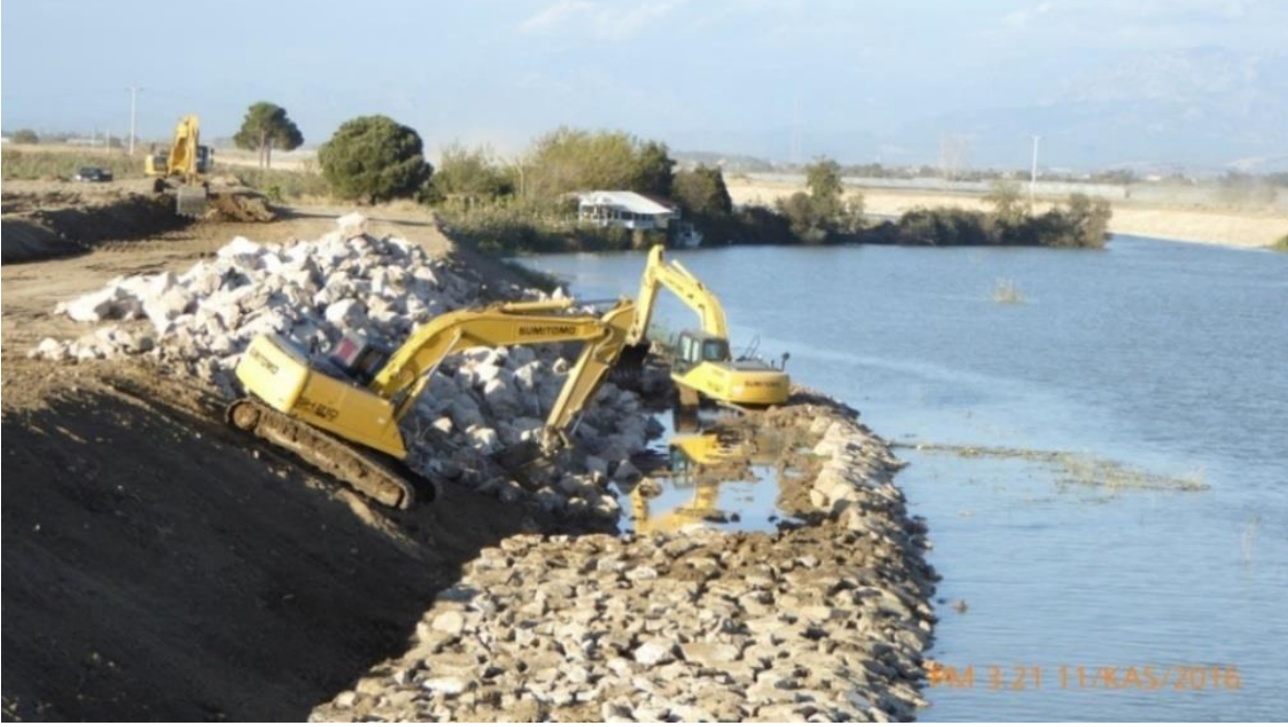
Şekil 6. Aksu Çayı'nın aşağı havzasındaki yapılaşma ile değişen nehir duvarı habitatları, 2016
