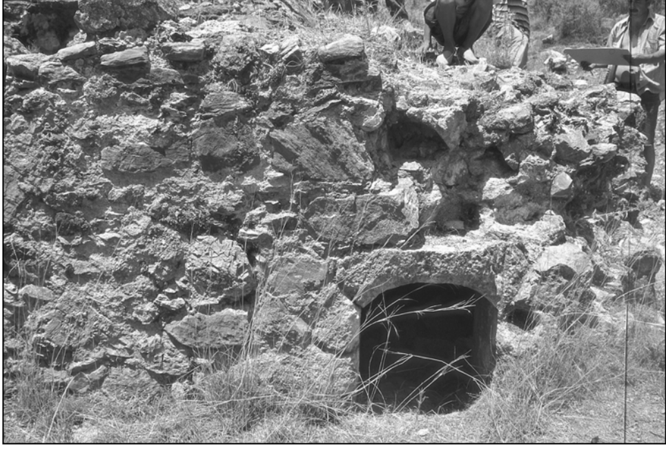
Levha 15. Akcami Köyü Hamam, güney cephe, ayrıntı
