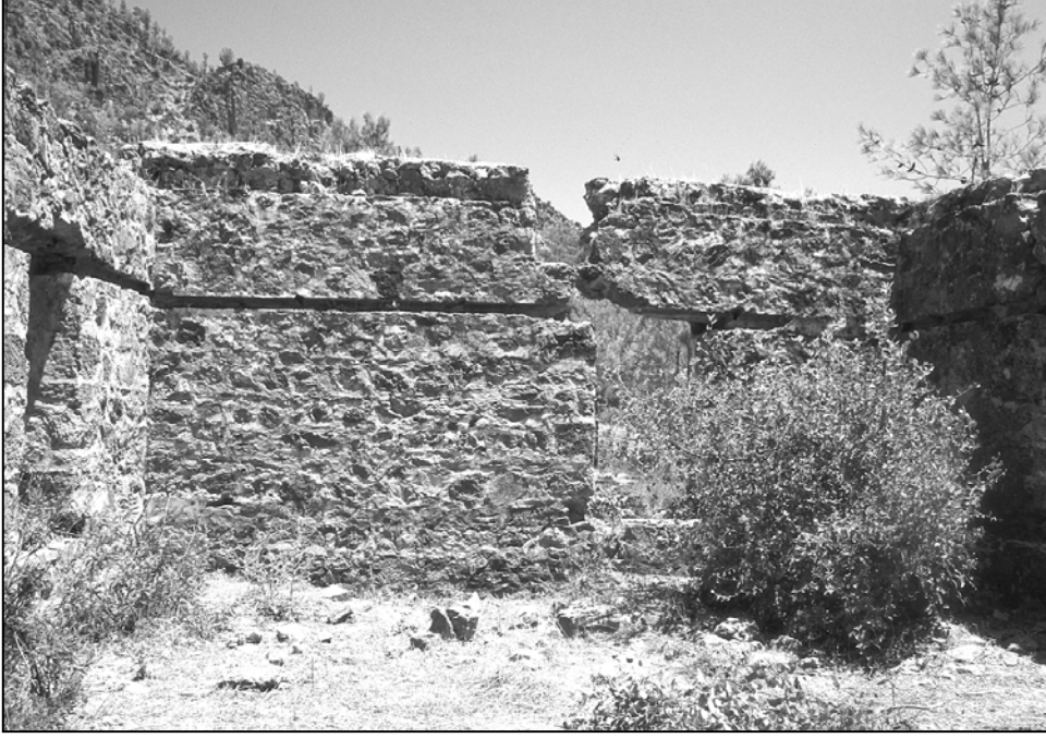
Levha 9. Akcami Ky Camii, harim, batı duvar
