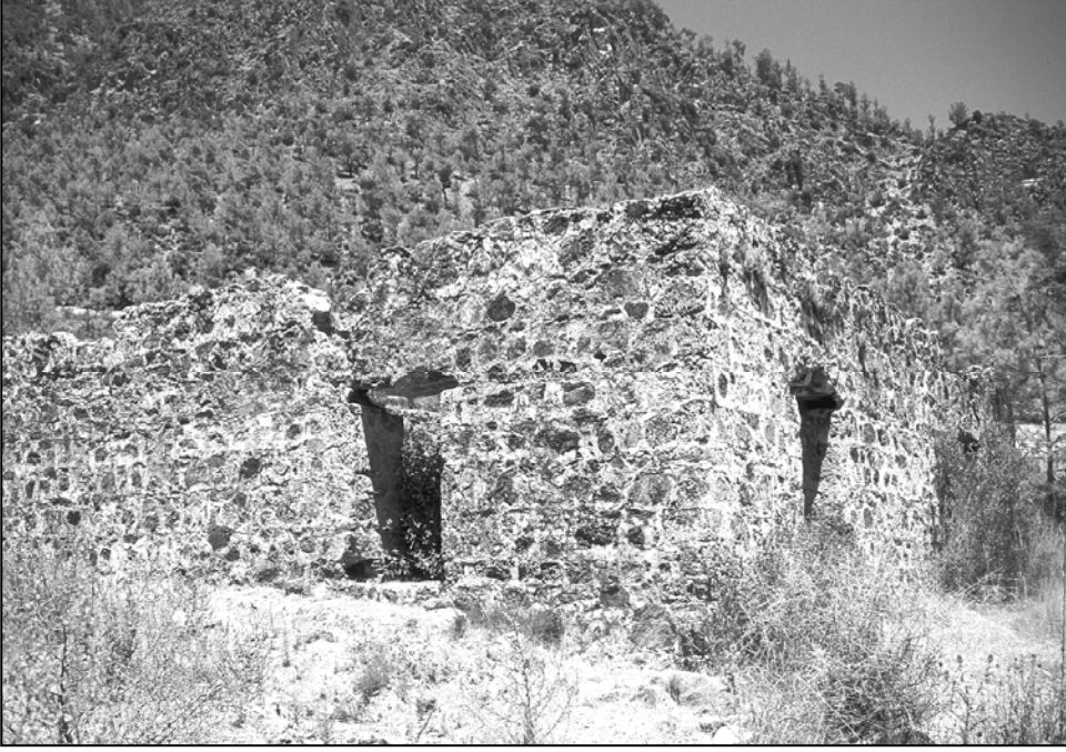
Levha 5. Akcami Köyü Camii, batı ve güney cephe
