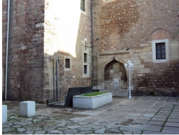
Şekil 3.10. Küçük avludaki teknik mekân girişi ve çeşme
