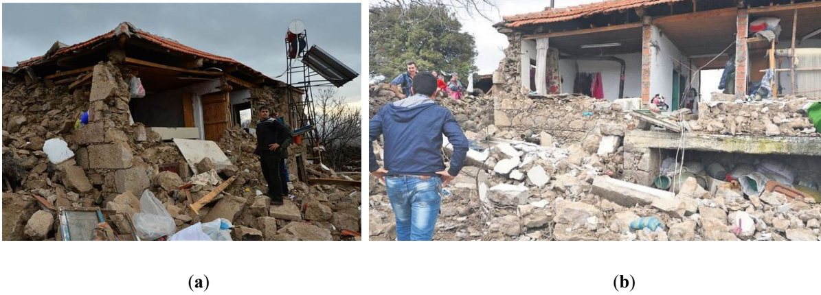
Figure 1 Structural damage photo with news in newspapers a) “Çanakkale’de 5.3 büyüklüğünde bir deprem daha”, Hürriyet Gazetesi [23] b) “Ege’de Panik”, Sabah Gazetesi [24]
