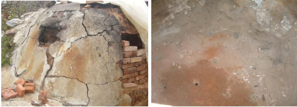
Şekil 4: H. Çokan'a ait fırının tuğla örülü açıklığı ve ızgara bölümü Kaynak: Fotoğraf Sevcan Ölçer, 2011
