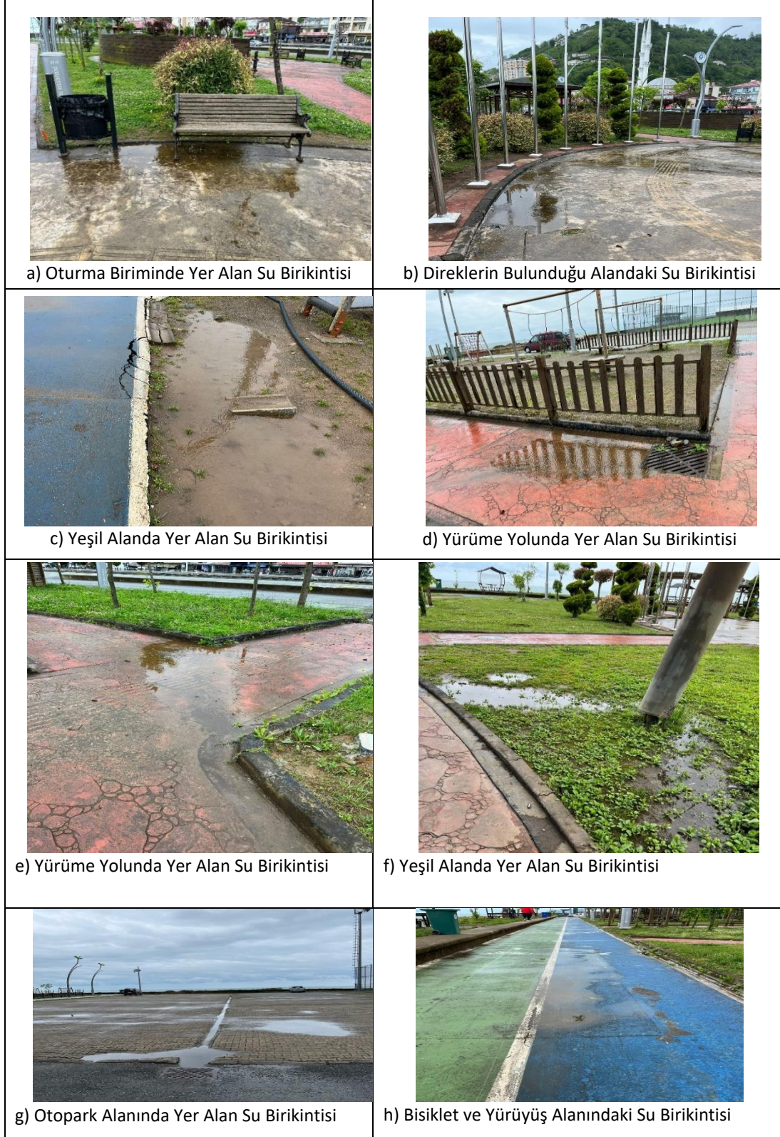
Şekil 9. Doğu Parkı'nın çeşitli noktalarındaki drenaj problemleri
