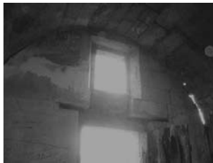
Resim 52. Naos Batı Duvar.
