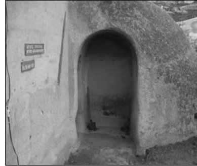
Resim 41. Kuzey Cephe, Giriş.
