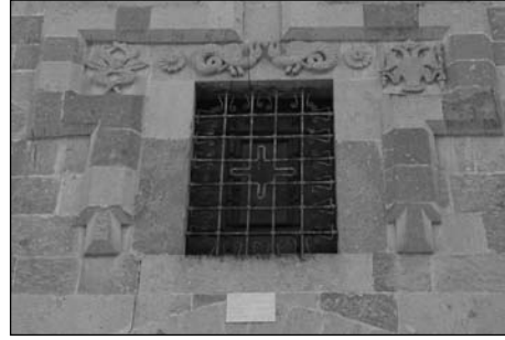
Resim 13. Batı Cephe, Üst Seviye Penceresi ve Kabartma Bezemeler.
