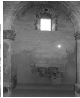
Resim 47. Orta Nef Batı Duvar.
