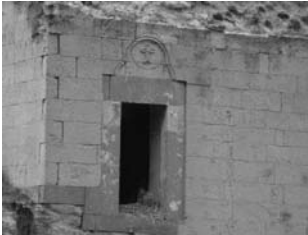
Resim 51. Güney Cephe, Kapı.
