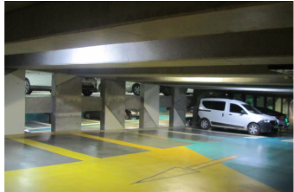
Şekil 29. Otopark içerisinde yarım kat kullanımı (yazar 1)
