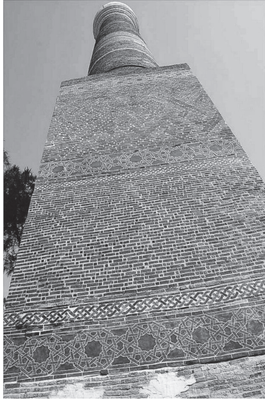
Resim 15: Siirt Ulu Camii, minarenin kaide kısmındaki on kollu yıldızlardan oluşan tezyinatın restorasyon sonrasındaki genel görünümü
