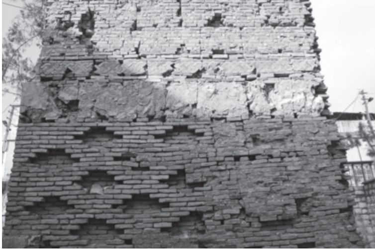
Resim 4: Siirt Ulu Camii, minarenin kaide kısmındaki sırsız ve sırlı tuğlalarla meydana getirilmiş baklava motiflerinin onarım öncesindeki durumları.
