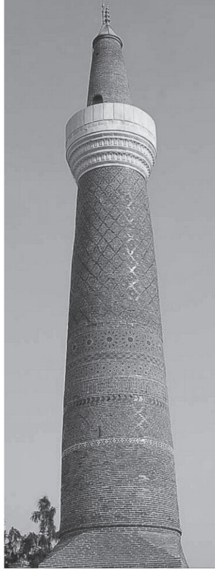
Resim 17: Siirt Ulu Camii, minare gövdesinin restorasyon sonrasındaki görünümü.
