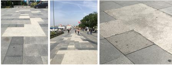
Şekil 28. Zemin Döşemesindeki Beton Dolgular (Kutsal Göllü, 2018)
