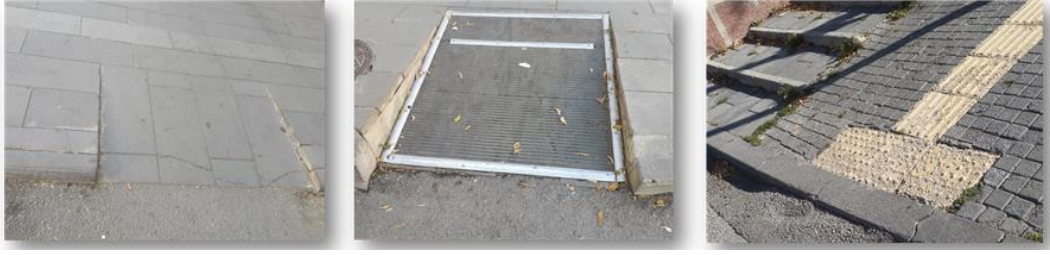
Şekil 7. Araştırma alanında tespit edilen rampalardan görünüm (özgün)
