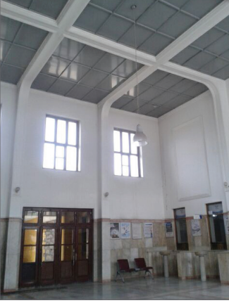
Şekil 25 Gar Binası Camlı Bölme (Merve K., 2017)
