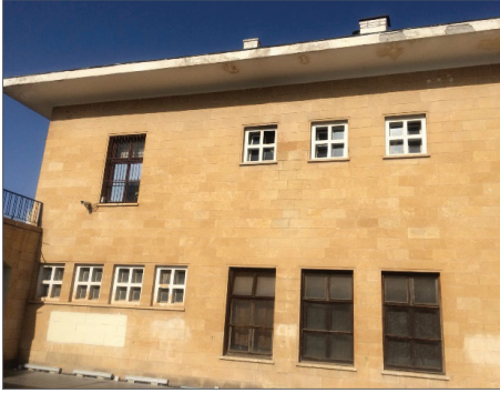
Şekil 23 Gar Binası Batı Cephe, (Merve K., 2018)
