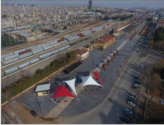
Şekil 18 Gaziantep Gar Binası ve Çevre Birimler, (Türkan Uzun, 2018)
