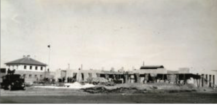
Şekil 8 Gaziantep Tren Garı İnşası 31
