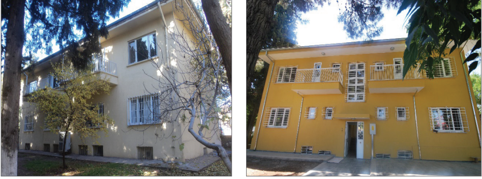
Şekil 46 TCDD Lojman 5-1 Restorasyon öncesi ve sonrası (G. Antep KUDEB arşivi)
