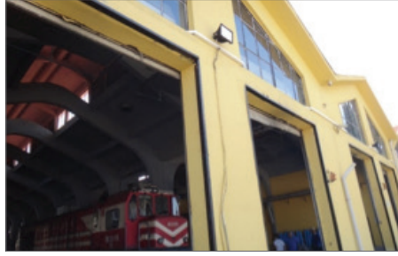
Şekil 48 Tren Bakım İstasyonu, 2013
