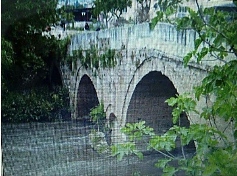
Fotoğraf 20 Nilüfer Hatun Köprüsü Tahliye Gözleri (Erkan Atak'tan)
