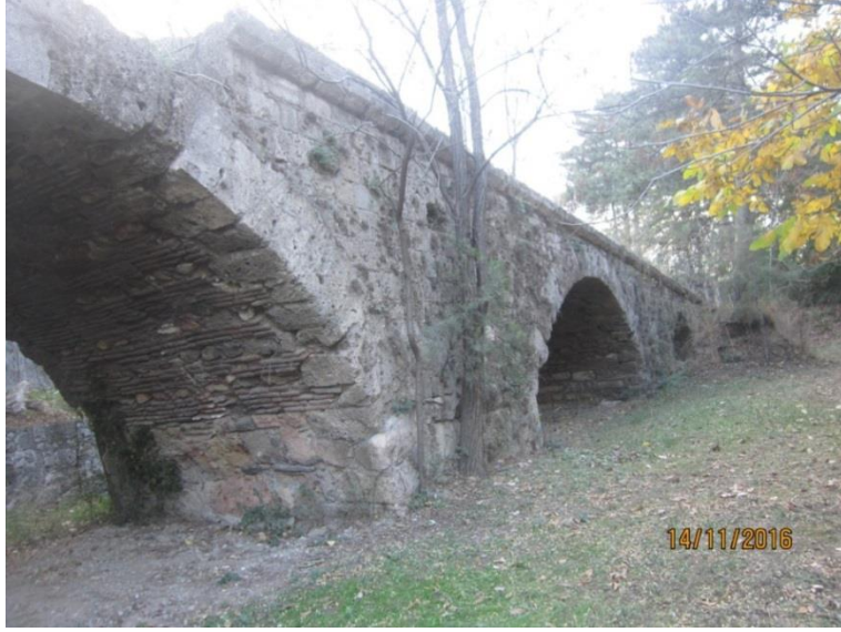
Fotoğraf 21: Mihraplı (Selçuk Hatun) Köprüsü Genel Görünümü
