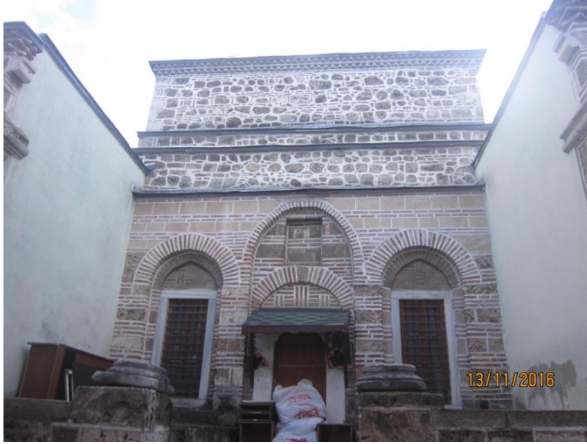
Fotoğraf 10: Gülçiçek Hatun Türbesi, Revak Bölümünden Görünüm
