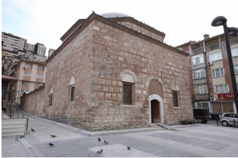
Fotoğraf 23: Emir Sultan Hamamı Genel Görünüm
