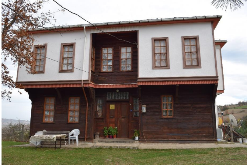
Fotoğraf 4: Konağın batı (giriş) cephesi
