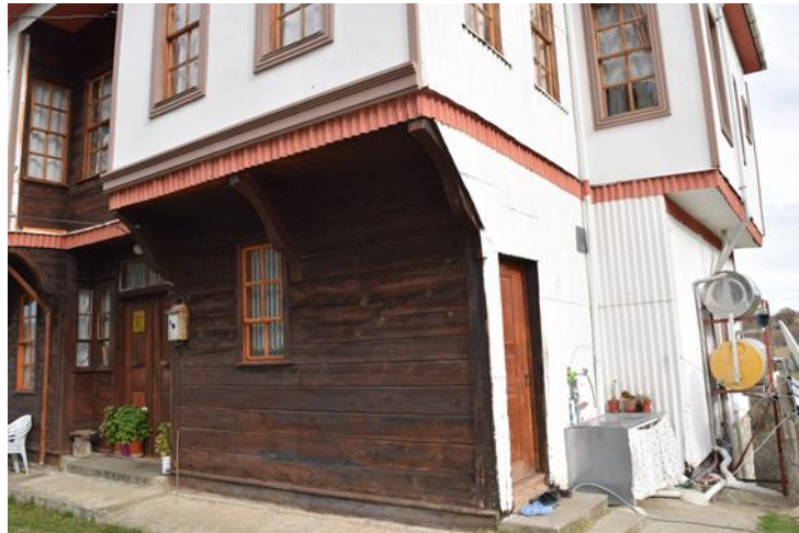
Fotoğraf 5: Üst katta batı cepheden oda genişliğinde çıkma yapan güneybatı odası
