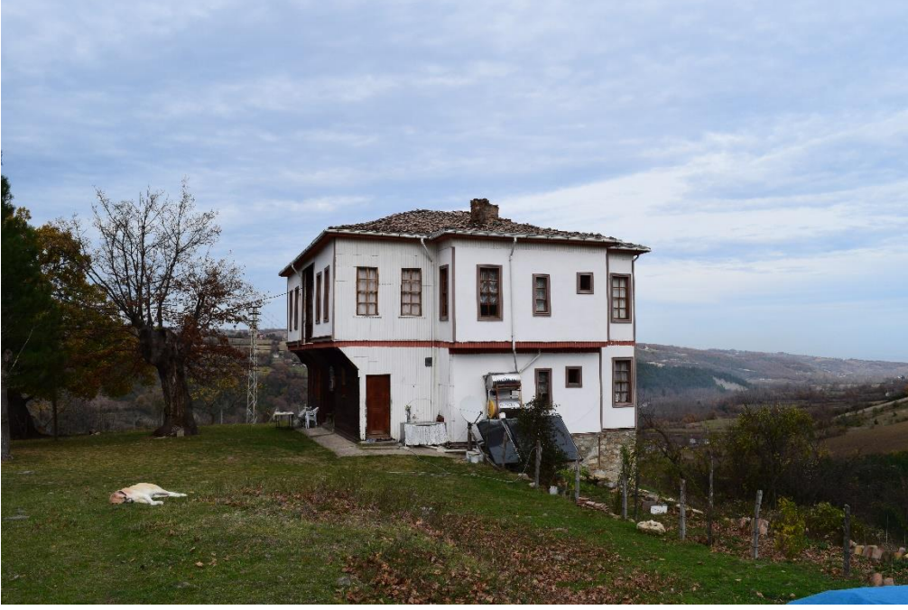
Fotoğraf 1: Konağa güney cepheden bakış
