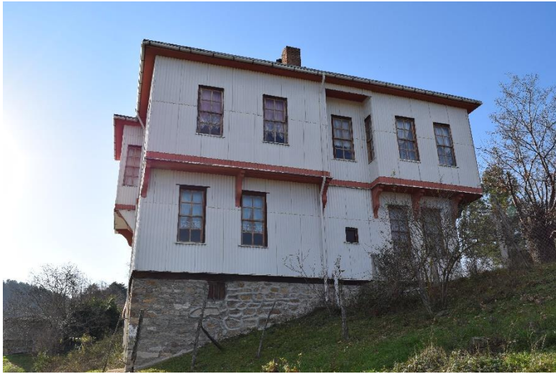
Fotoğraf 7: Doğu ve kuzey cephelerde çıkma yapan cumba ve odaların profilli ahşap konsollarla desteklenmesi
