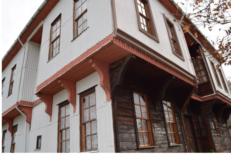
Fotoğraf 6: Üst katta batı ve kuzey cephelerden çıkma yapan kuzeybatı odası
