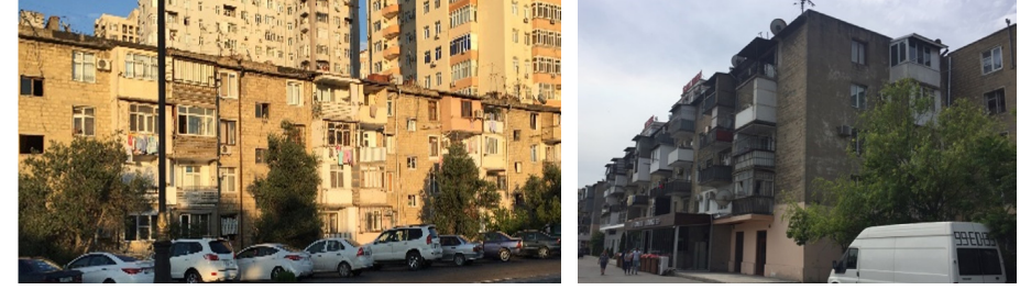
Görsel 13. I – 450 A Seri No. Toplu Konut Yapısı-1960 (Solda)
