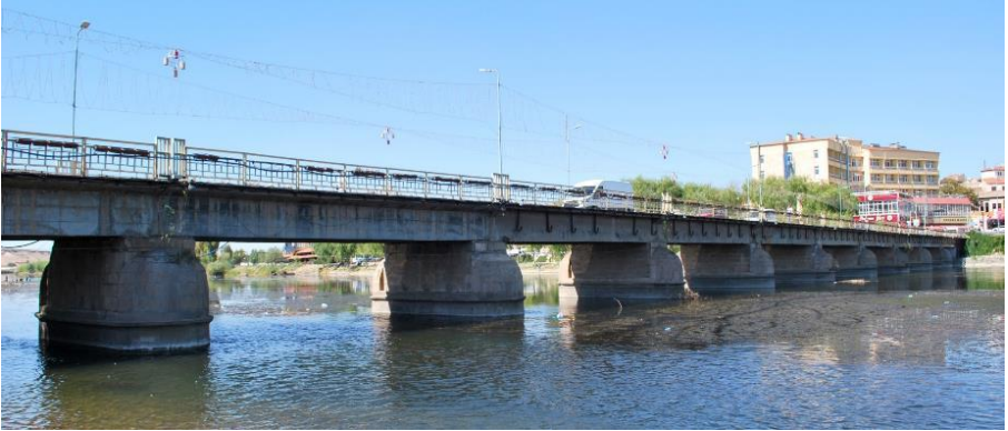
Foto. 15: Avanos Köprüsü'nün Menba Tarafından Görünüşü.
