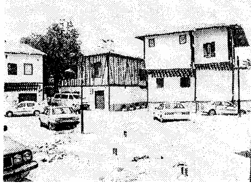
Resim 5.Doyran Sokak No.:5,7,9-Kale Restoran,Antika Mobilya Evi
