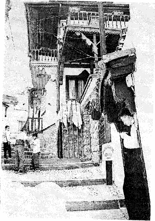
Resim 8. Berrak Sokak No.: 7 - 7C - Boyacızâde Restoran
