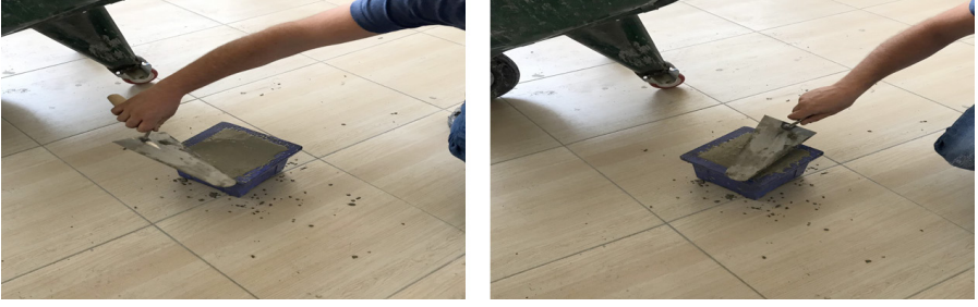
Şekil 3. Betonun kalba yerleştirilmesi
