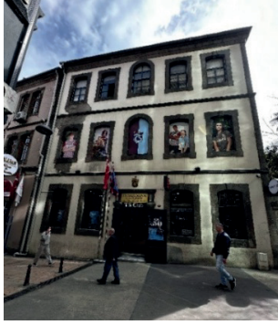
Fotoğraf 19. Mektep binasının ön cephesi. (Foto: N. Yazıcı, Mart 2025).
