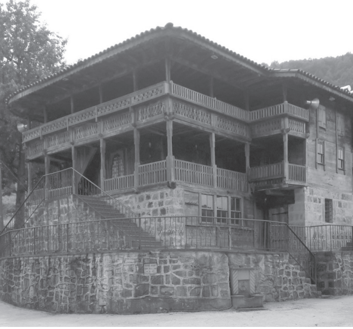
Foto 1: Bilen Köyü Camii Kuzeydoğu Cephe
