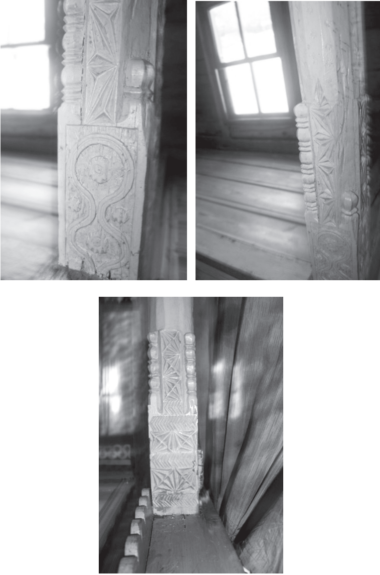
Foto 17-18-19: Mahfilde bulunan Üst Örtüyü Taşıyan Ahşap Direkler
