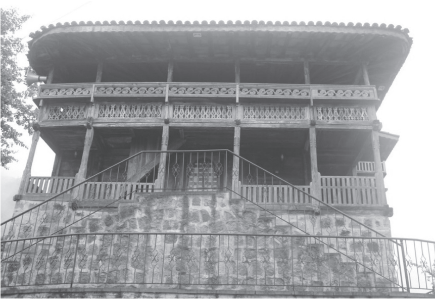
Foto 2: Bilen Köyü Camii Kuzey Cephe
