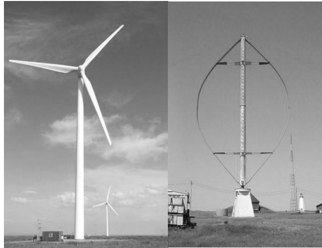
Şekil 2. Yatay eksenli ve dikey eksenli rüzgar türbini
