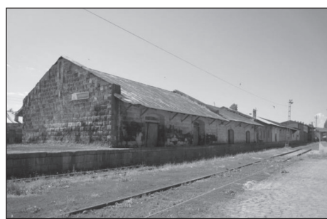
Resim 35: Kars İstasyonu/Ambar Binası
