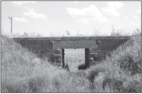
Resim 05: Doğukapı-Akyaka Arası/ 3 Nolu Menfez
