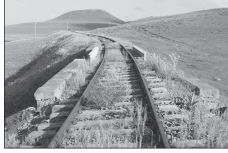
Resim 14: Akyaka-Başgedik/1 Nolu Demir Tablalı Köprü Üstten Görünüşü
