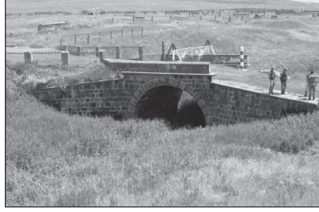
Resim 02: Doğukapı-Karayolu/Şose Sınır Köprüsü (1878)
