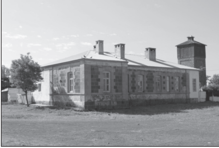
Resim 30: Kars İstasyonu/ 4 Nolu Lojman-Şehir Cephesi
