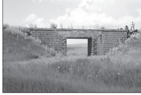
Resim 08: Doğukapı-Akyaka Arası/ 2 Nolu Köprü
