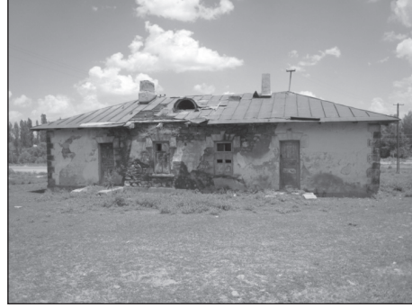
Resim 26: Akyaka İstasyonu/ 1 Nolu İşçi Barakası
