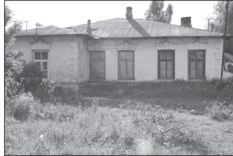
Resim 29: Kars İstasyonu/ 23 Nolu Lojman-Ray Cephesi
