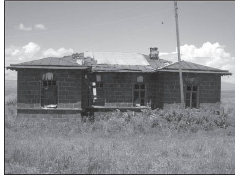
Resim 27: Mezra İstasyonu/ 2 Nolu Lojman Binası
