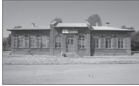
Resim 22: Akyaka İstasyonu/Şehir Cephesi
