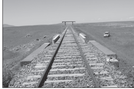
Resim 16: Akyaka-Başgedik/2 Nolu Demir Tablalı Köprü Üstten Görünüşü
