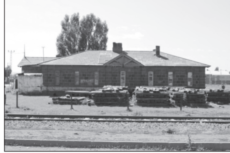
Resim 31: Kars İstasyonu/ 9 Nolu Lojman-Ray Cephesi
