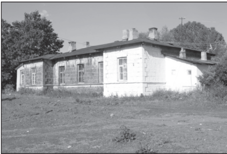
Resim 28: Kars İstasyonu/ 2 Nolu Lojman-Ray Cephesi
