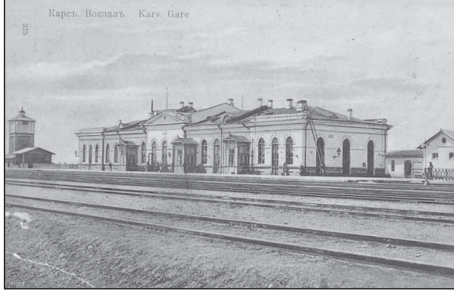
Resim 23: Kars Eski İstasyon Binası/ Peron Cephesi
