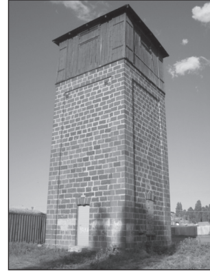
Resim 33: Kars İstasyonu/ Su Kulesi
