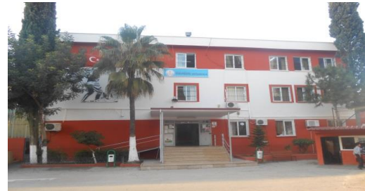
Şekil 2. Vakıfbank Ortaokulu ön cephe görünüşü
