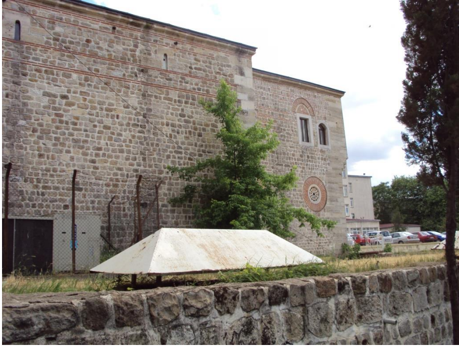
Fotoğraf 8: Deveci Han'ın Kuzey Cephesi
