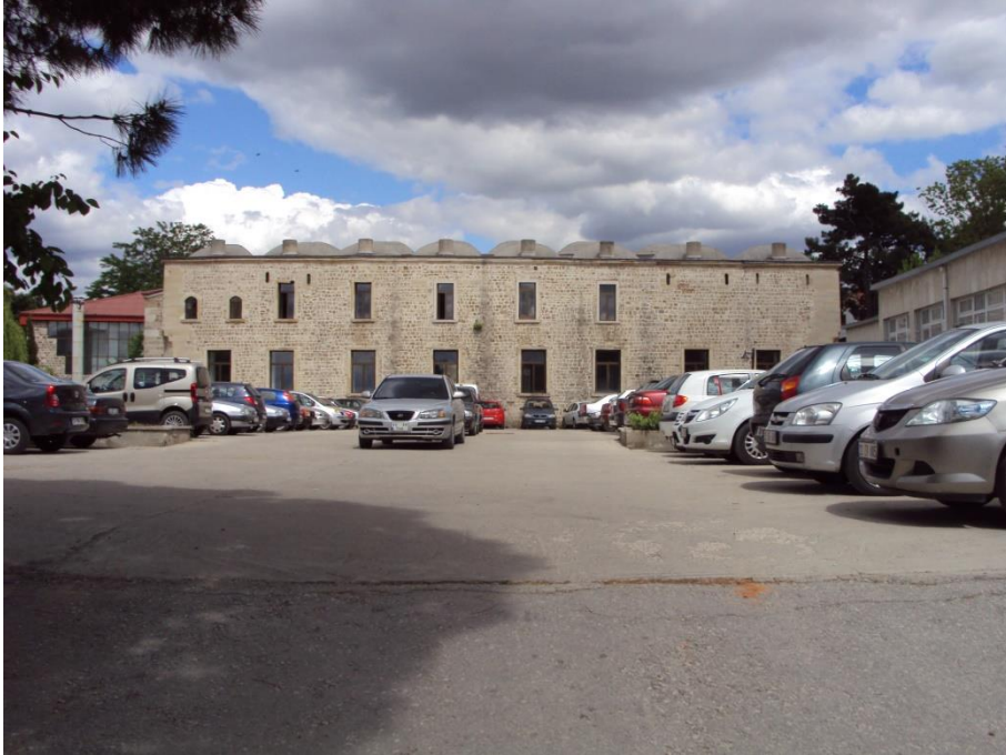
Fotoğraf 7: Deveci Han'ın Batı Cephesi
