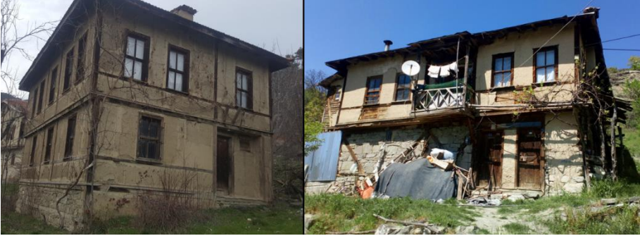
Şekil 8. İyi Durumdaki Konut Yapıları
