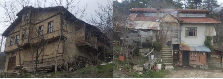
Şekil 5. Geleneksel Konut Yapısı ve Yeni Yapılaşma
