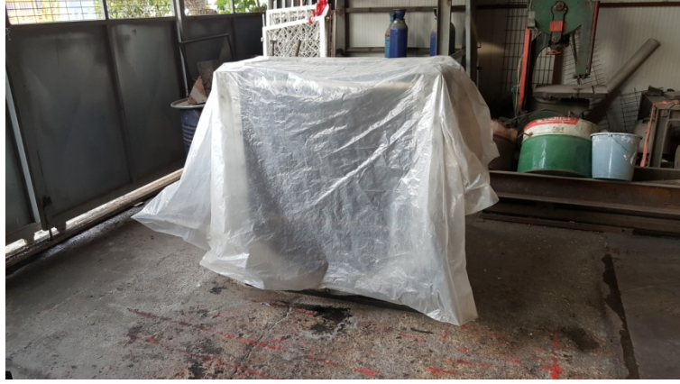
Görsel 6. Çimento Dökümü Sonrası Sıcaklık Koruması
