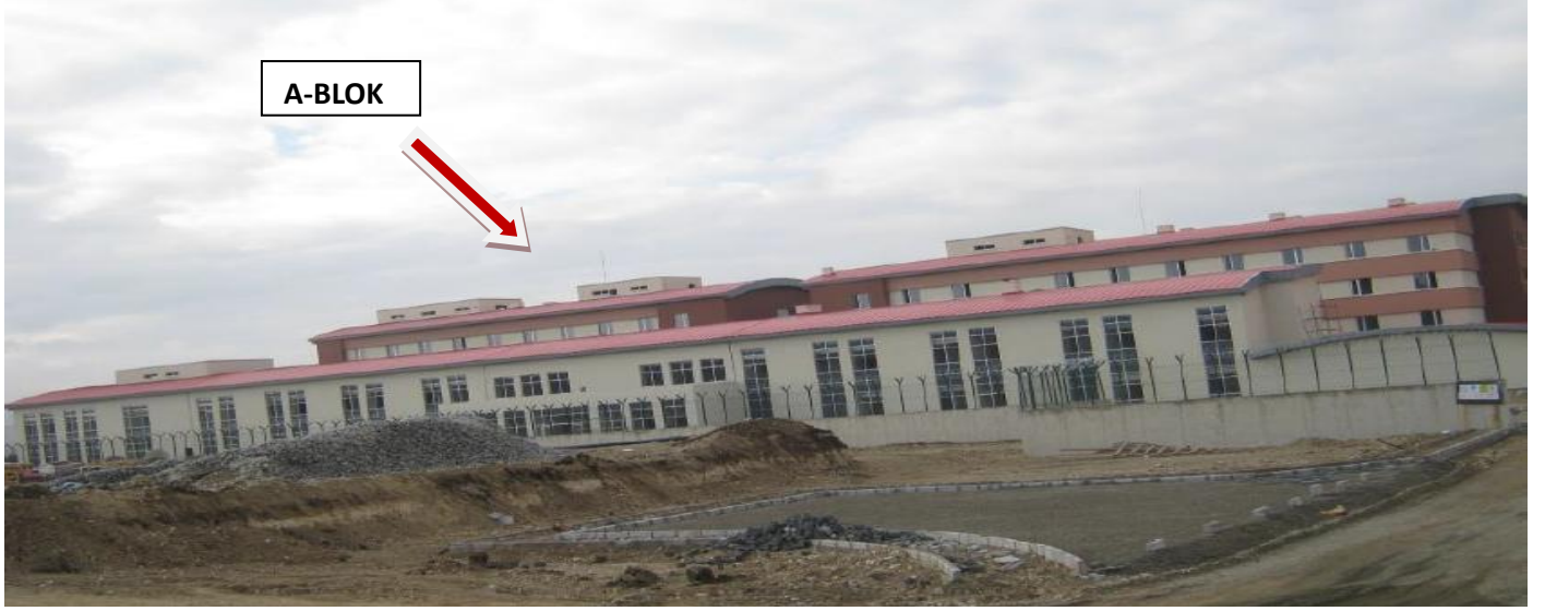
Resim 1. Gaziantep kabul, tarama ve barınma merkezi inşaat şantiyesi görünüşü
