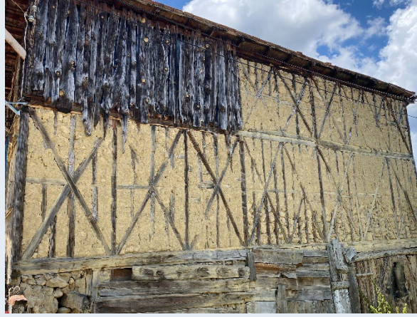
Görsel 29: Hımış sistemle inşa edilen duvar (Yazar arşivi, 2026).
