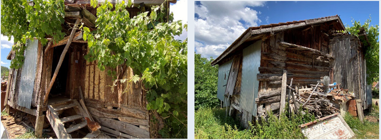
Görsel 17: Giriş (güney) cephesi (Yazar arşivi, 2026).
