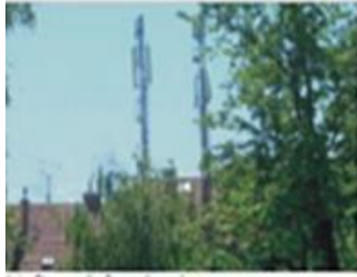
a-Cep telefonu baz istasyonu
