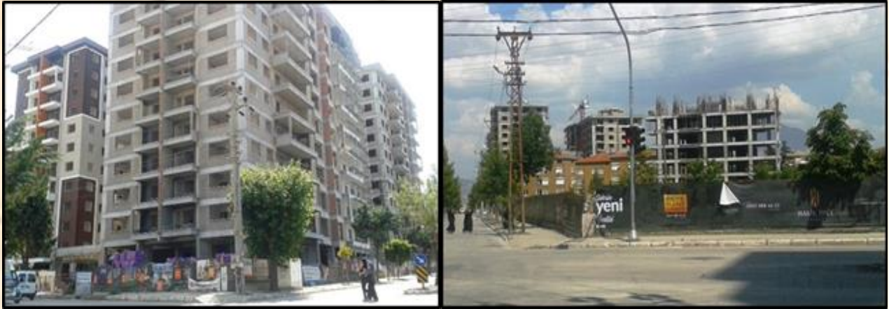
Şekil 3.1. Isparta İli, Gülistan Mahallesi’ndeki kentsel dönüşüm çalışmaları.
