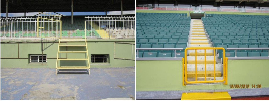
Şekil 26. Konya Atatürk Stadyumu (solda) ve Büyükşehir Stadyumu'nda (sağda) Tribünlerden Sahaya Açılan Acil Çıkış Kapıları
