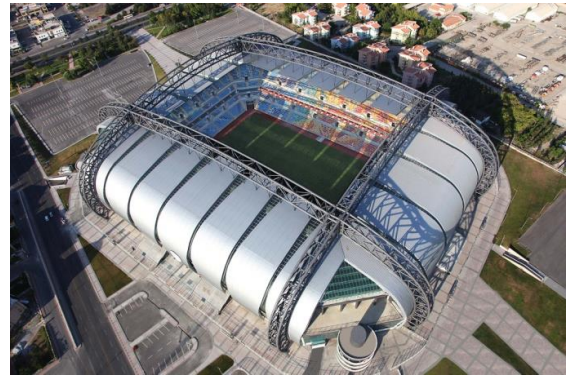
Şekil 14. Kayseri Kadir Has Stadyumu (BKA Mimarlık)
