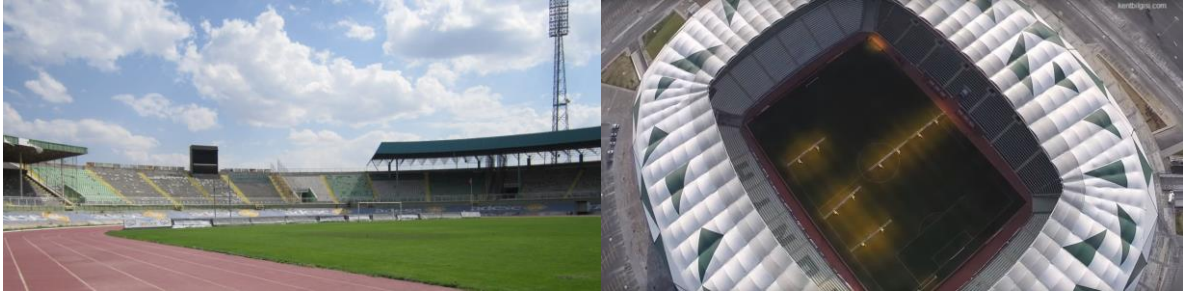
Şekil 29. Konya Atatürk Stadyumu Kuzey Tribünleri (solda) ve Büyükşehir Stadyumu'nda (sağda) Kullanılan Solaryum Panelleri
