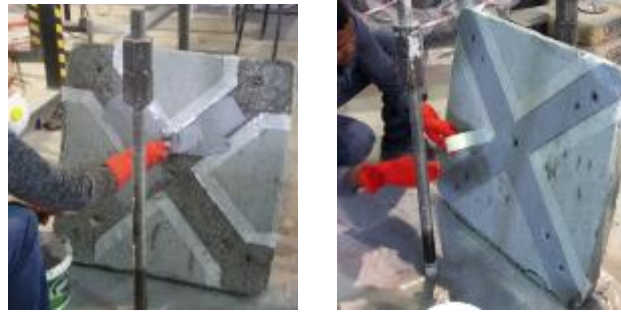
Şekil 8. Tamir harcının duvara uygulanması
