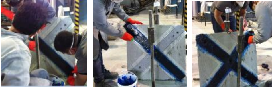
Şekil 10. LP şeritlerin yerleştirilmesi
