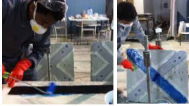
Şekil 9. Epoksi yardımıyla LP malzemesinin yapıştırılması
