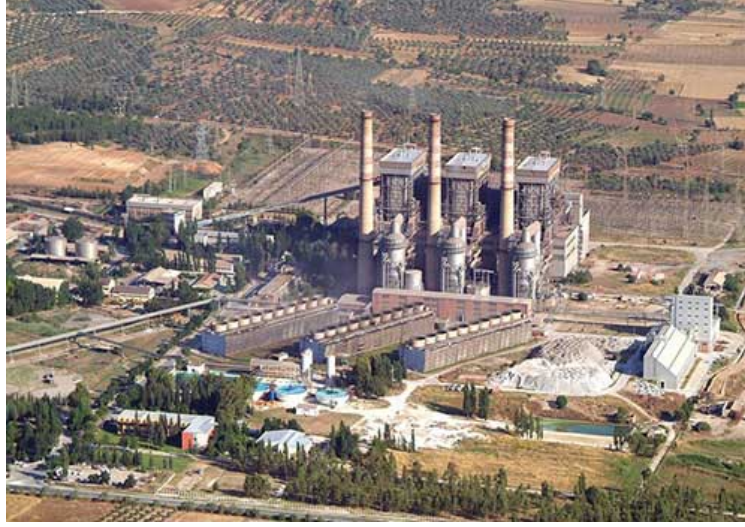
Şekil 2. Yatağan Termik Santrali Görünümü (Bereket Enerji, 2017)
